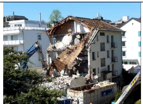
Sommer 2014, Haus Abbruch.
